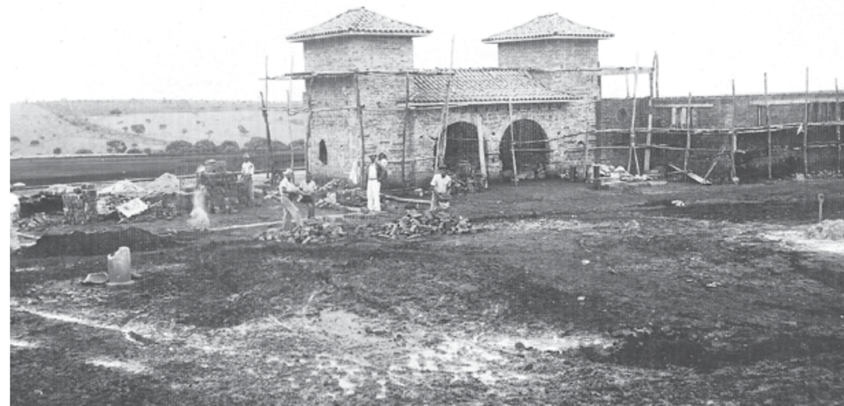
A cidade assiste ao começo da construção do Estádio Fausto Alvim.
