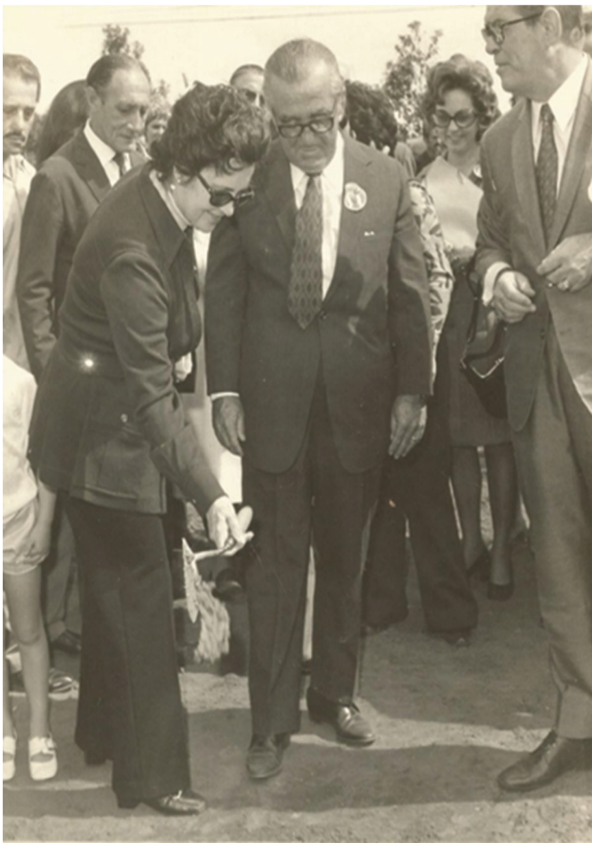
Lançamento Da Pedra Fundamental Da Construção Do Predio Proprio Da Apae
