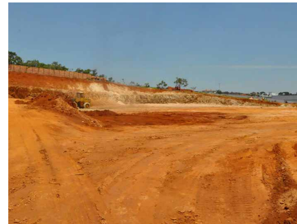
Início das obras da Unidade de Pronto Atendimento (UPA Municipal). 2015. Acervo Assessoria de Comunicação/PMA.
