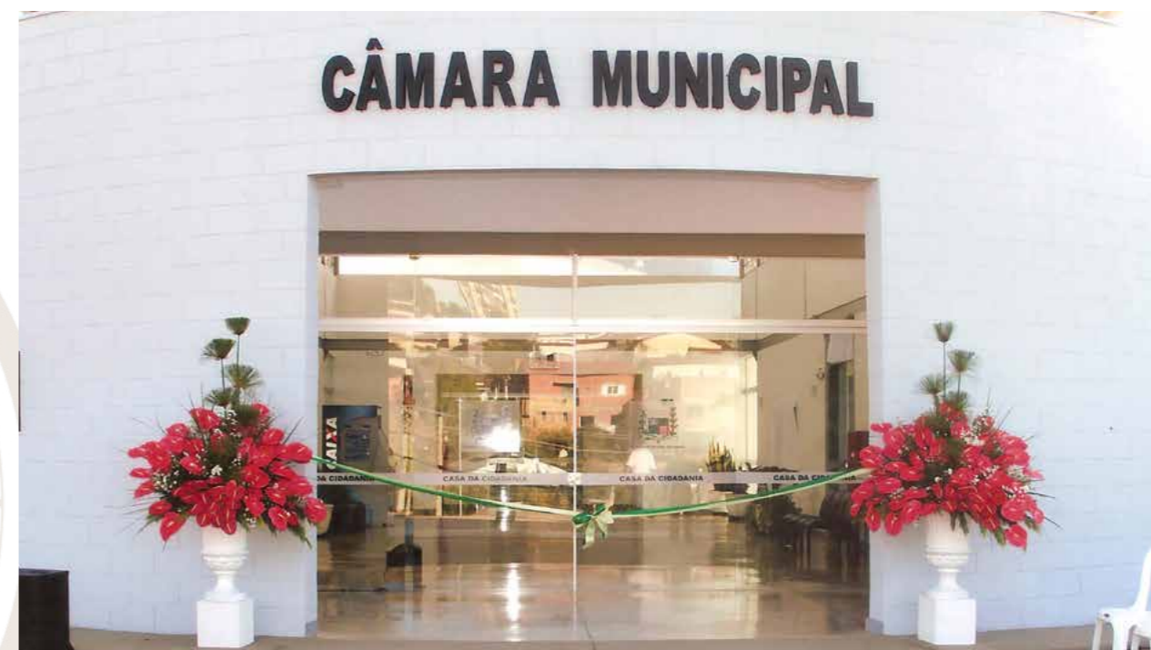
Acesso principal da Câmara Municipal. 2011. Acervo Câmara Municipal.
