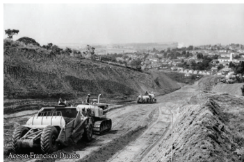
1975 - obras de construção da avenida Senador Montandon
