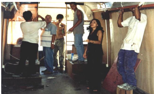
a) Instalação elétrica
