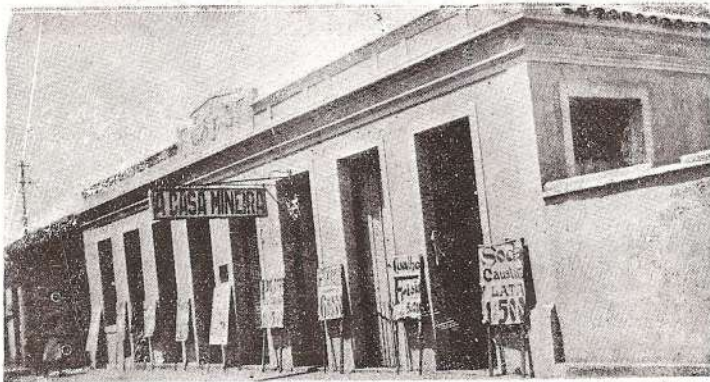
O prédio da "Casa Mineira"
