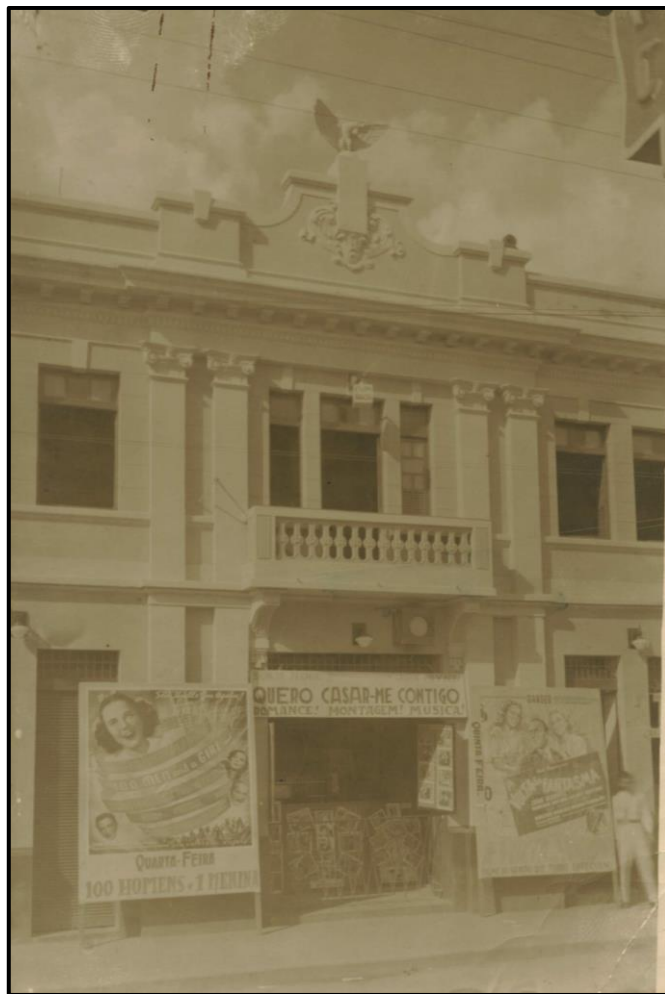
Figura 24 – Fachada do Cine-theatro Brasil, no início da década de 1940. (Fonte: FCCB)
