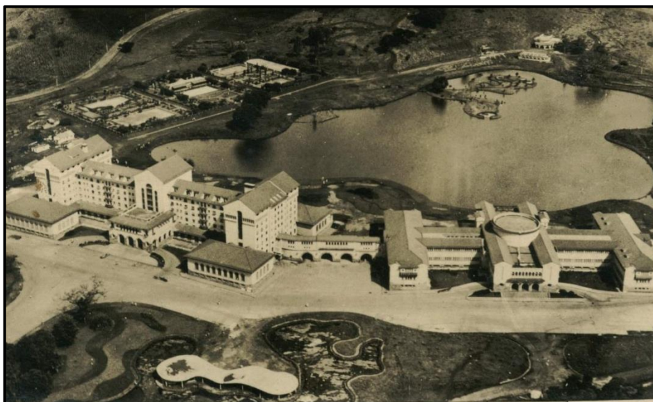
Figura 06 – Vista aérea do Complexo Hidrotermal do Barreiro. Ao centro o Grande Hotel e abaixo, com estrutura ondulada, a Fonte Andrade Júnior. (Fonte: FCCB)
