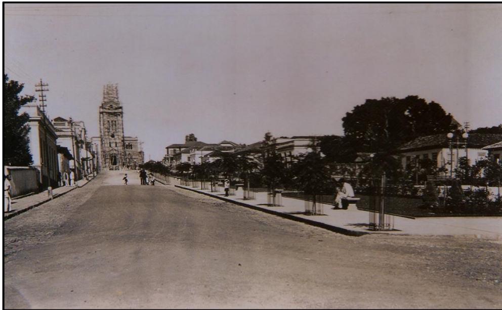
Figura 01 – Fase final da construção da Igreja Matriz de São Domingos. (Fonte: FCCB)
