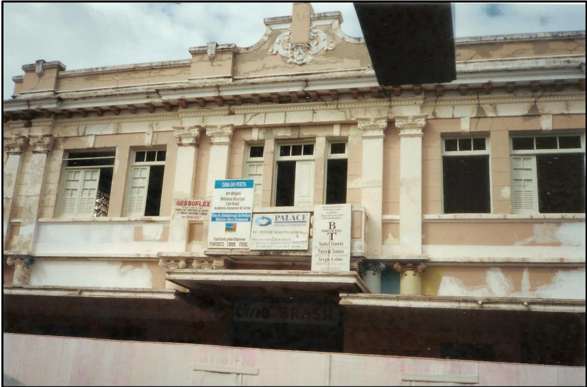
Figura 31 – Vista externa do prédio passando por reformas para abrigar a Casa do Poeta. Ano: 2000. (Fonte: FCCB)
