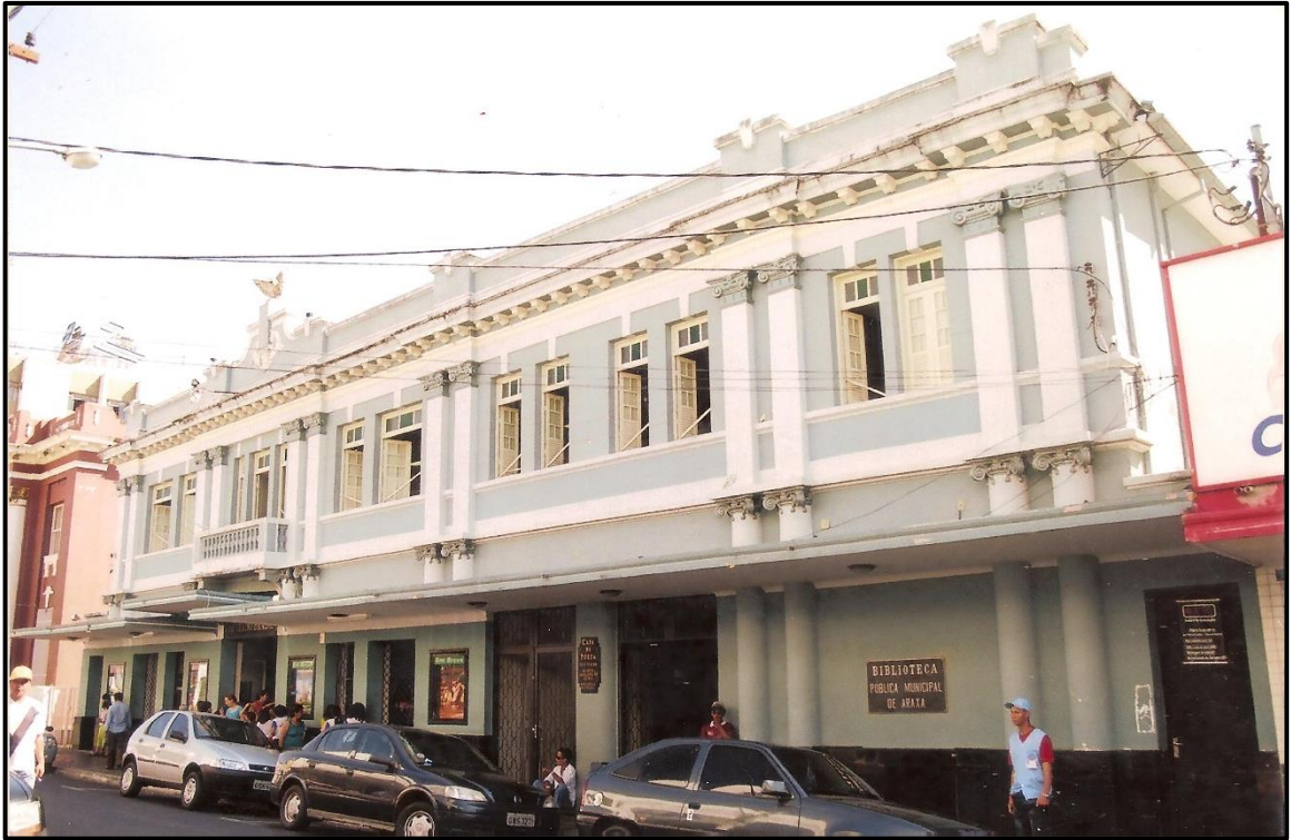
Figura 35 – Fachada do Cine Brasil após reforma. Ano: 2008. (Fonte: FCCB)
