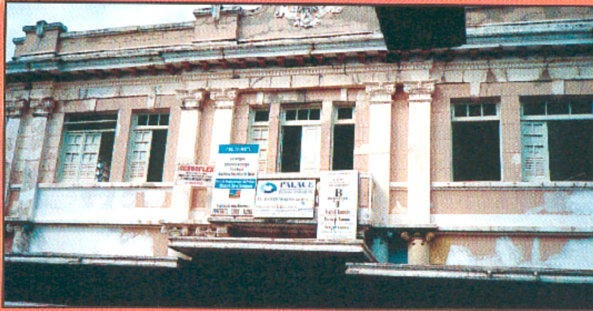
Fachada do prédio do Clube Brasil em reforma para abrigar a Casa do Poeta. 2000.
