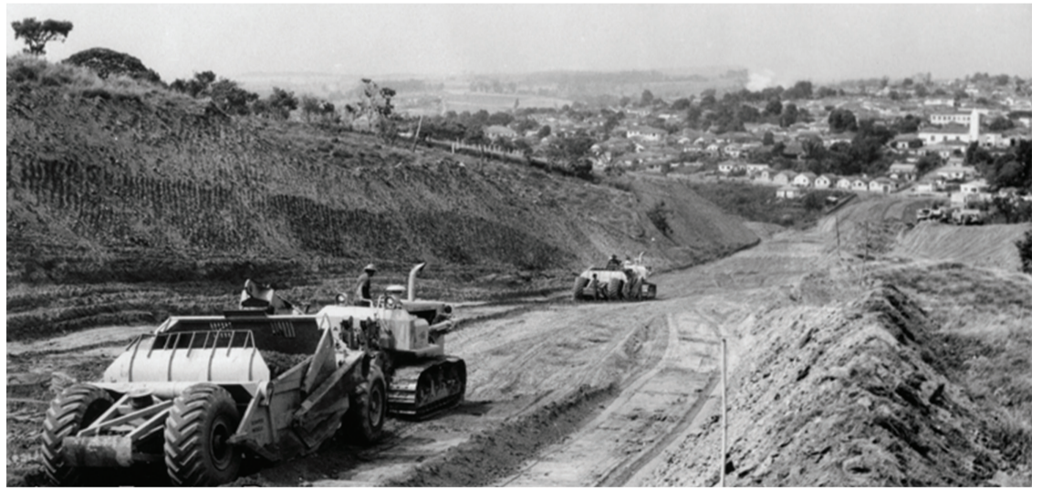
1975 - obras de construção da avenida Senador Montandon
