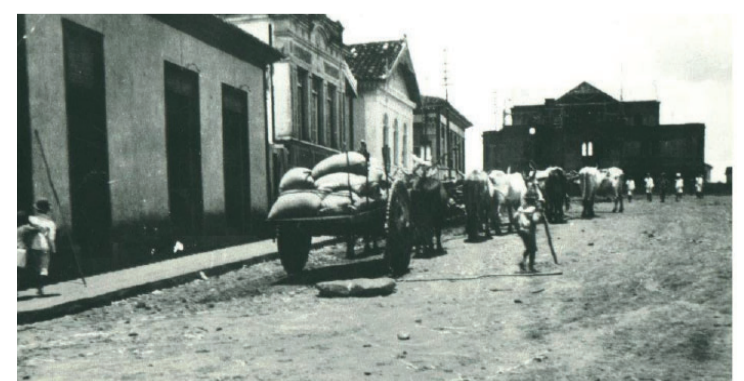
Construção da nova Igreja Matriz de São Domingos – Década de 20
