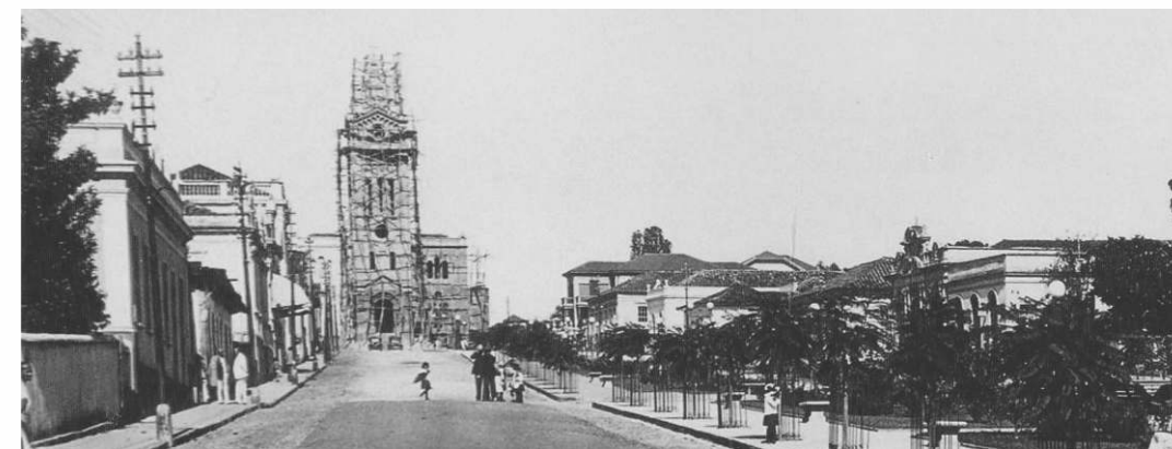
Igreja Matriz de São Domingos em construção. Década de 1940. Arquivo SAPP/FCCB
