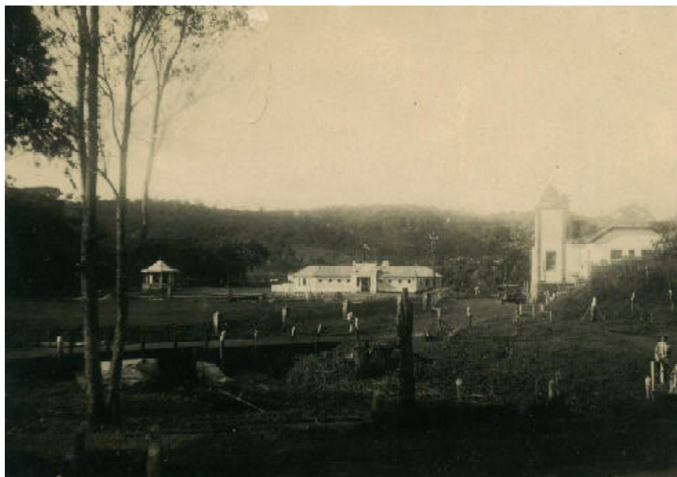
109. O Barreiro após os primeiros melhoramentos No centro, a casa de banhos
