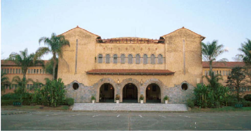
202. Termas - fachada frontal (porção central)
