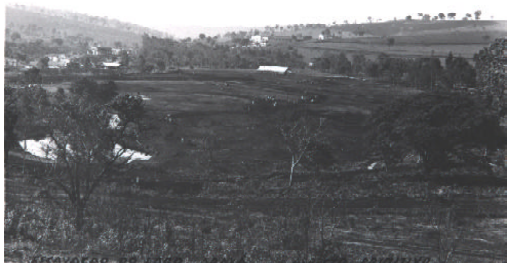
152. Escavação do Lago Superior
