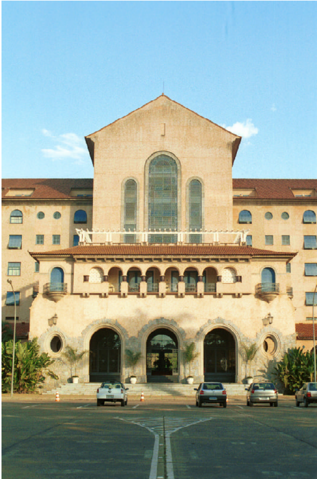
174. Grande Hotel - porção central da fachada frontal
