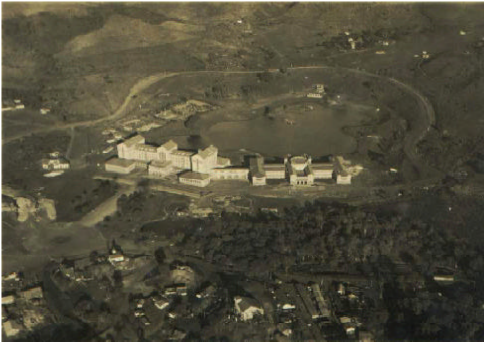
148. Vista aérea do Barreiro à frente, o Grande Hotel e as Termas, ao fundo, o Lago Superior e a Avenida do Contorno
