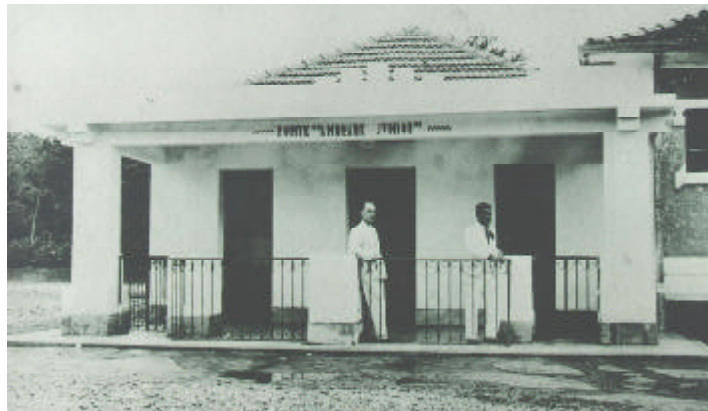
262. Antigo pavilhão da fonte sulfurosa
