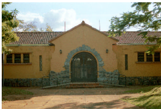
232. Praça de Esportes - vestiários: fachada frontal
