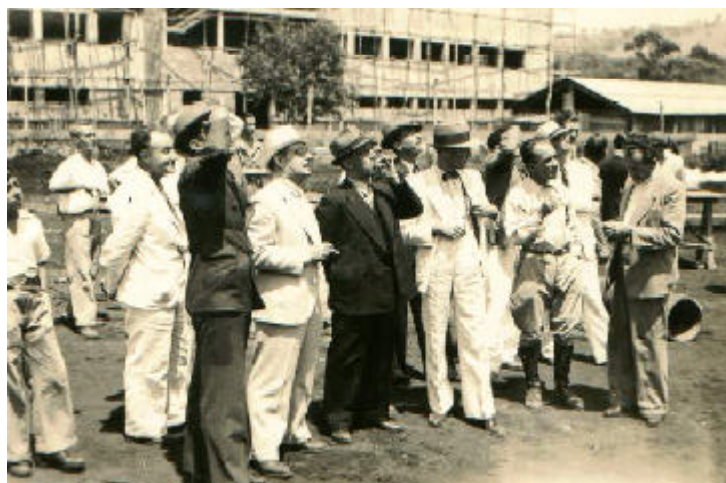
169. Visita de autoridades às obras do Barreiro. Signorelli é o terceiro da direita para a esquerda, de terno claro
