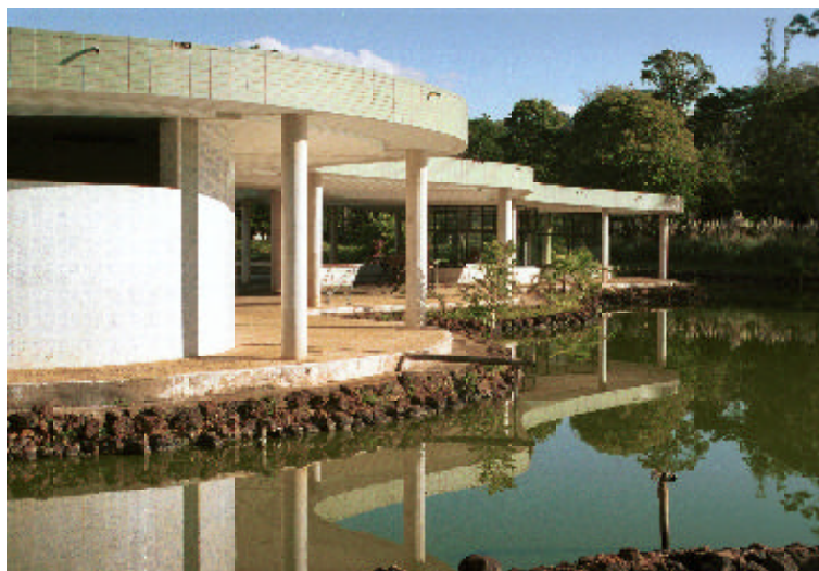
271. Fonte Andrade Júnior - situação atual, sem o pano de vidro
