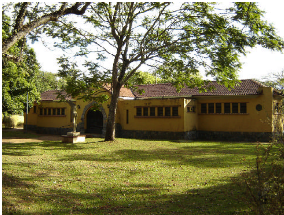
231. Praça de Esportes - vestiários: vista frontal
