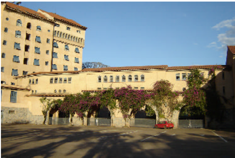
197. Passarela entre o Grande Hotel e as Termas
