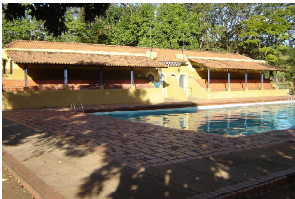
233. Praça de Esportes - vestiários (fundos) e piscina
