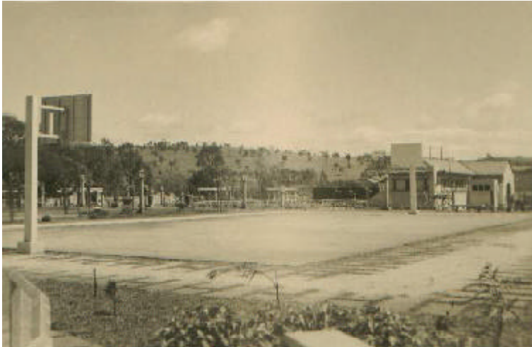
235. Praça de Esportes quadra; ao fundo, o bloco dos vestiários
