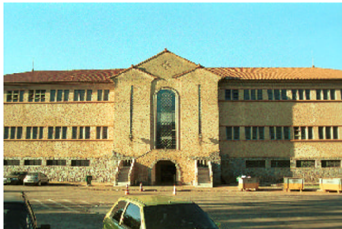
211. Termas fachada lateral acesso ao subsolo e ao sanatório
