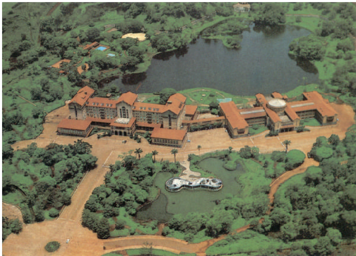
334. Vista aérea do balneário
